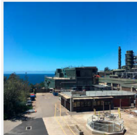
Biogás de aguas residuales utilizado para generar electricidad en la Planta de Tratamiento de Aguas Residuales de North Head, Sidney, Australia.
